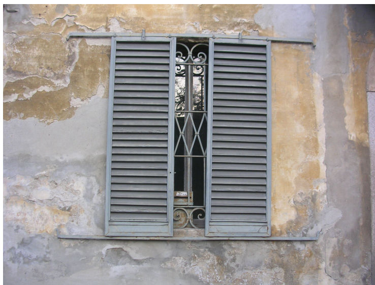
Particolare del serramento scorrevole. Edificio n°29 a Gera
