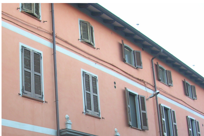
Particolare della gronda. Edificio n°32 a Gera
